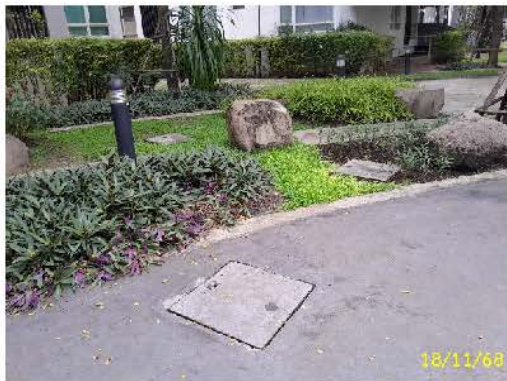
บ่อเติมอากาศ
