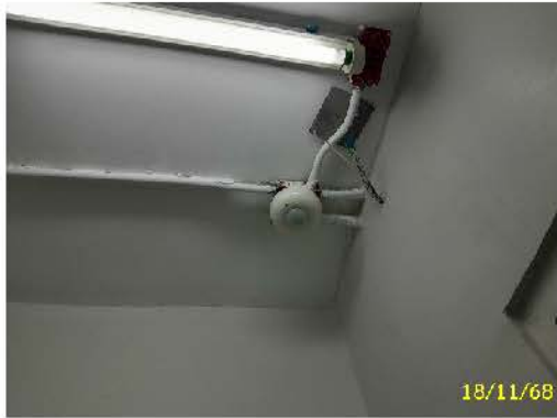
สวิตซ์ไฟแบบอัตโนมัติ
