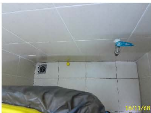
ก๊อกน้ำ และรูระบายน้ำ ห้องขยะประจำชั้นอาคาร 7
