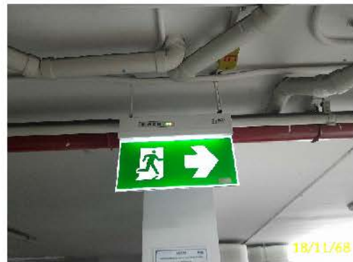
ป้ายบอกทางหนีไฟ
