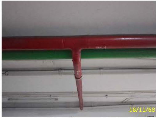
ท่อน้ำดับเพลิง
