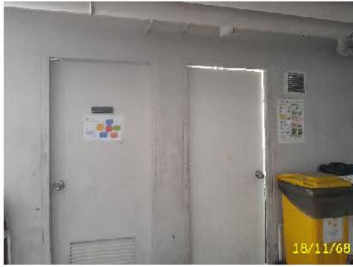
ห้องขยะรวมประตูปิดสนิทอาคาร 6
