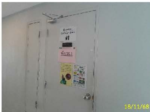
ห้องขยะประจำชั้นประตูปิดสนิทอาคาร 7
