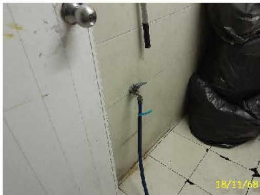
ก๊อกน้ำห้องขยะรวมอาคาร 6
