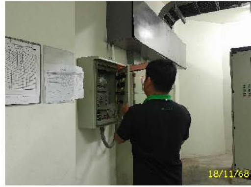
ตู้ควบคุม
