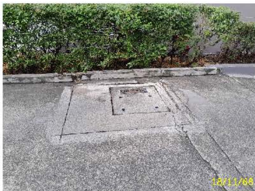
ท่อระบายน้ำรอบโครงการ
