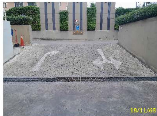
รางระบายน้ำฝน
