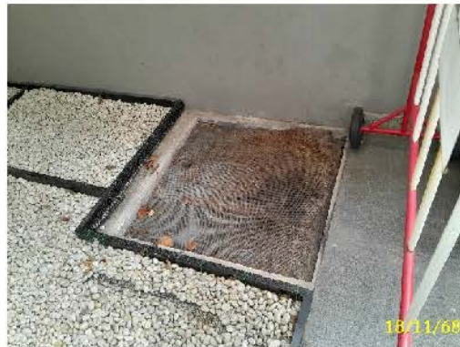
ระบายน้ำชั้นใต้ดิน
