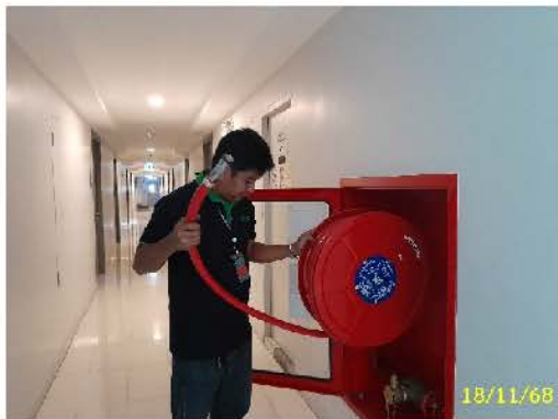
ตู้ดับเพลิง
