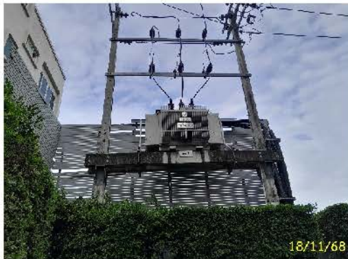
หม้อแปลงไฟฟ้า อาคาร 6
