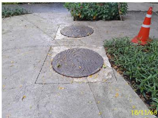
บ่อน้ำทิ้งหลังบำบัด
