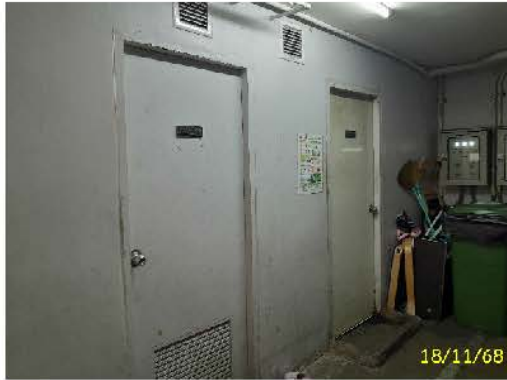
ห้องขยะรวมประตูปิดสนิทอาคาร 7
