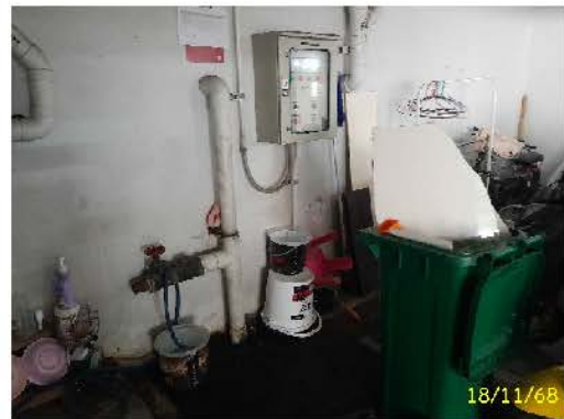
บ่อรวบรวมน้ำจากห้องขยะรวมอาคาร 6
