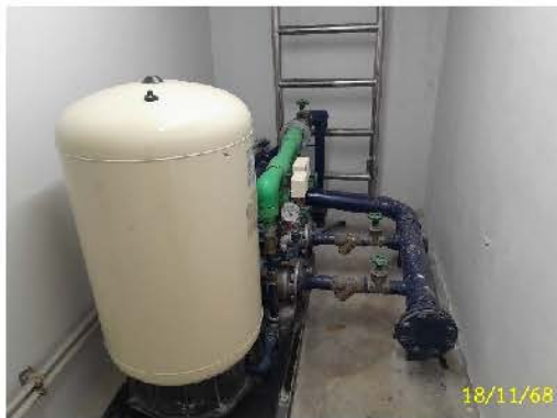
ปั้มน้ำใช้ชั้นดาดฟ้า อาคาร 7
