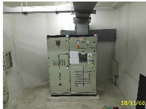
MDB ห้องไฟฟ้าอาคาร 7
