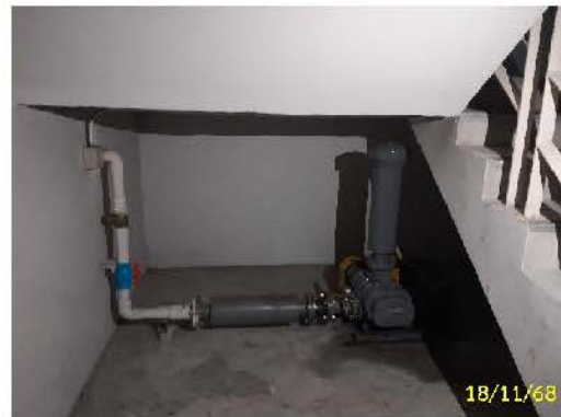
เครื่องเติมอากาศ
