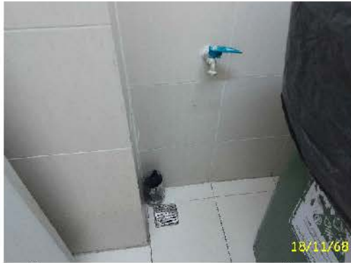
ก๊อกน้ำ และรูระบายน้ำ ห้องขยะประจำชั้นอาคาร 6
