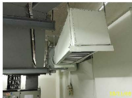
พัดลมระบายอากาศ ห้องไฟฟ้าอาคาร 6
