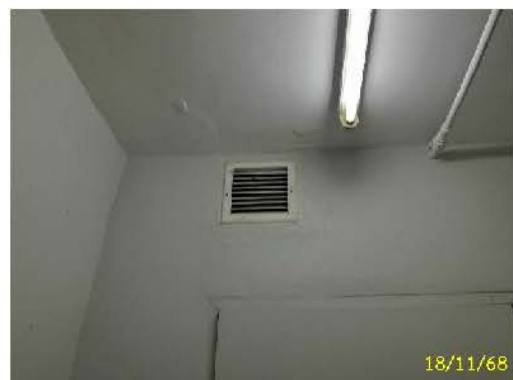
ระบายอากาศ ห้องขยะประจำชั้นอาคาร 7
