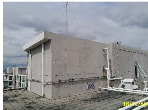
ถังเก็บสำรองน้ำชั้นดาดฟ้า อาคาร 7
