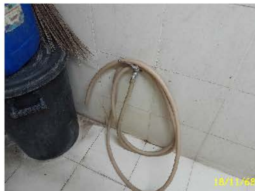
ก๊อกน้ำ ห้องขยะรวมอาคาร 7
