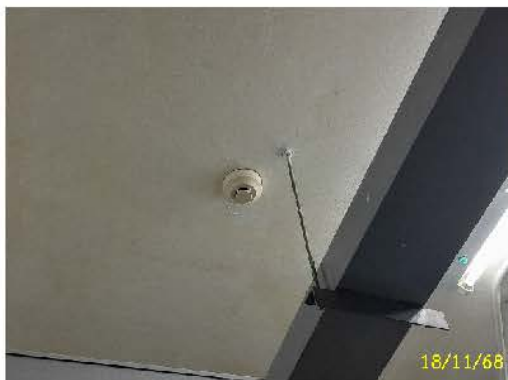
เครื่องตรวจจับควันอาคาร 7
