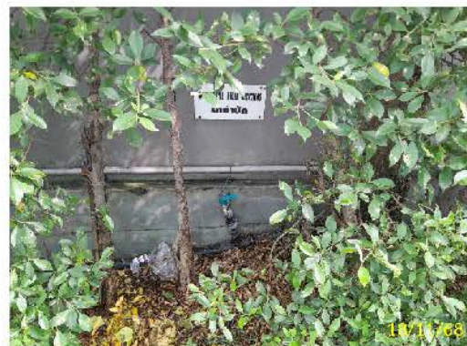
ระบบน้ำทิ้งรดน้ำต้นไม้และป้ายบอกตำแหน่ง
