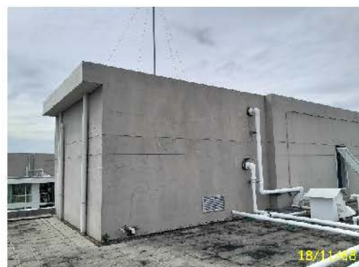
ถังเก็บสำรองน้ำชั้นดาดฟ้า อาคาร 6
