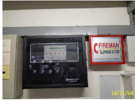
ระบบแจ้งเหตุอัคคีภัย
