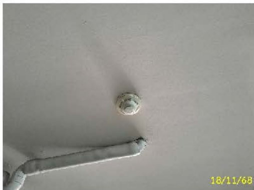
เครื่องตรวจจับความร้อน
