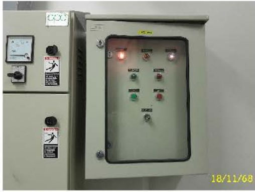
ตู้ควบคุมเครื่องเติมอากาศ
