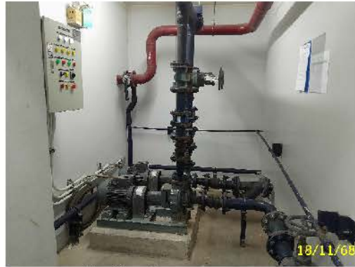
ปั้มน้ำใช้ชั้นใต้ดิน อาคาร 7
