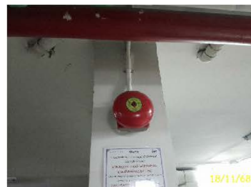
อุปกรณ์ส่งสัญญาณแจ้งเหตุ
