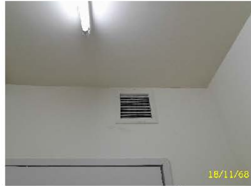
ระบายอากาศ ห้องขยะประจำชั้นอาคาร 6
