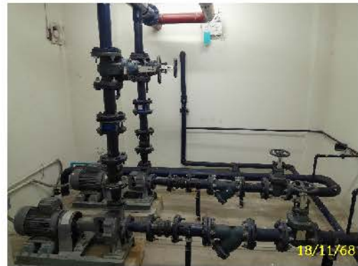
ปั้มน้ำใช้ชั้นใต้ดิน อาคาร 6
