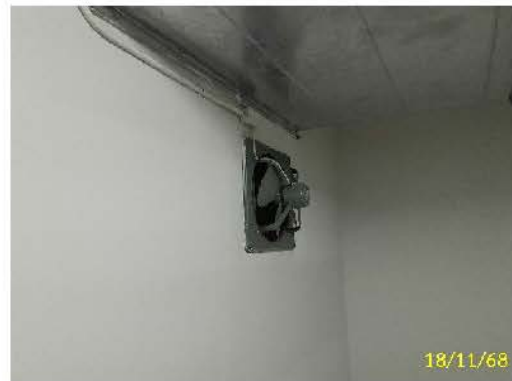
พัดลมระบายอากาศ ห้องไฟฟ้าอาคาร 7
