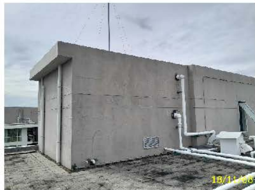
ถังเก็บสำรองน้ำชั้นตาดฟ้า อาคาร 6
