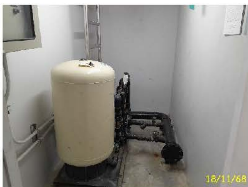
ปั้มน้ำใช้ชั้นดาดฟ้า อาคาร 6
