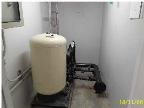
ปั้มน้ำใช้ชั้นตาดฟ้า อาคาร 6
