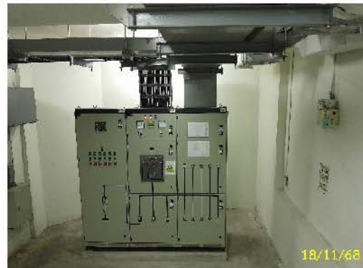
MDB ห้องไฟฟ้าอาคาร 6
