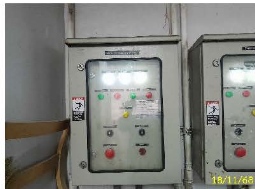
ตู้ควบคุมน้ำทิ้ง
