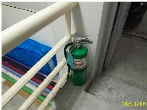
ถังดับเพลิง ห้องไฟฟ้าอาคาร 7
