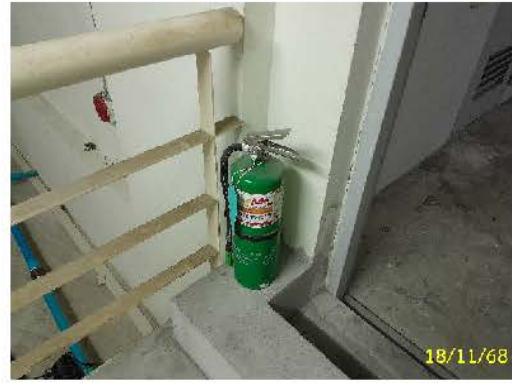
ถังดับเพลิงในห้องระบบไฟฟ้า
