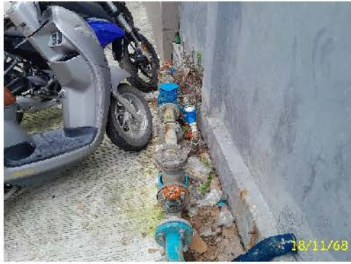
จุดเชื่อมต่อท่อประปาของการประปานครหลวง
