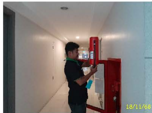
ถังดับเพลิง
