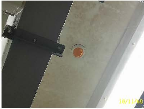
เครื่องตรวจจับควันอาคาร 6
